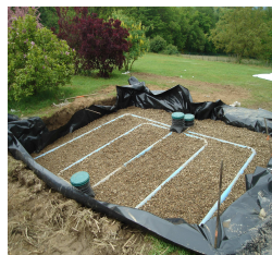
Mise en œuvre d'un filtre à sable, une technique simple mais qui doit être effectuée avec rigueur, seuls les regards restent visibles
