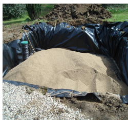
Mise en œuvre d'un filtre à sable, une technique simple mais qui doit être effectuée avec rigueur, seuls les regards restent visibles
