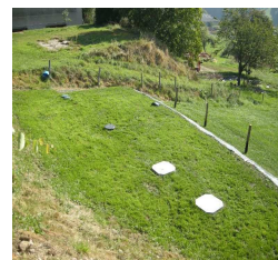
Mise en œuvre d'un filtre à sable, une technique simple mais qui doit être effectuée avec rigueur, seuls les regards restent visibles
