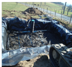
Mise en œuvre d'un filtre à sable, une technique simple mais qui doit être effectuée avec rigueur, seuls les regards restent visibles
