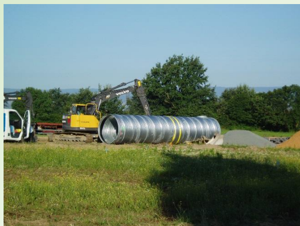
Figure 1 La gestion des eaux pluviales ça peut être la pose de cuve de rétention enterrée, mais c'est aussi une prise en compte dans l'aménagement global pour favoriser l'infiltration lorsque les conditions le permettent ou l'aménagement de nombreux petits espaces pour faire de la rétention : noues, espaces verts
