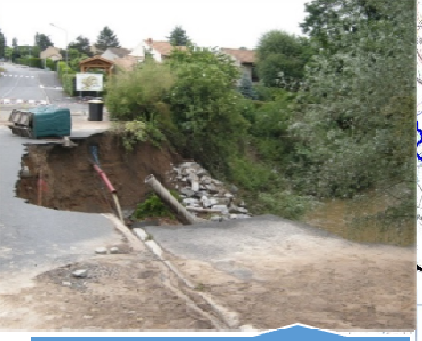
La confluence du Véрут avec la Coise. La route d'accès à la Thierry a été emportée par le Verut.
