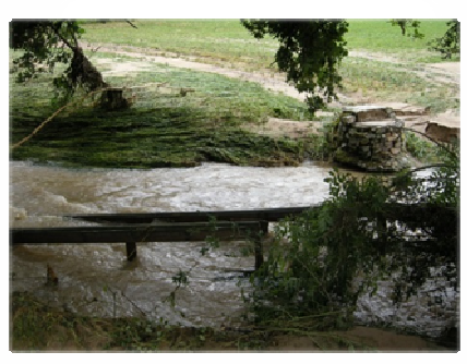
Entre Chamboeuf et Saint Bonnet les Oules : la passerelle sur le Volvon a été emportée. - 8 juin 2015 -
