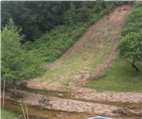
Le Véрут à Saint Galmier à l'aval du barrage (Glissement de terrain et comblement du lit du cours d'eau)
