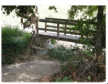
Deux mois après, la passerelle a été reposée. Le Volvon est sec. - 7 août 2015 -
