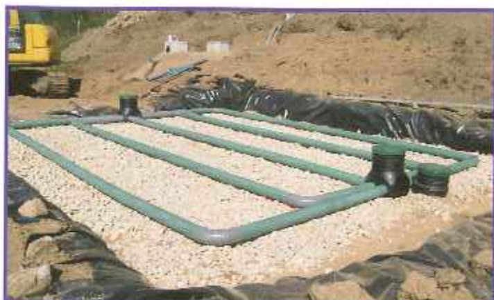
Répartition des eaux prétraitées sur le filtre à sable
