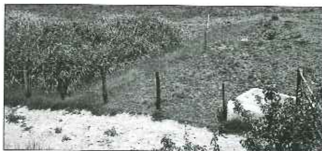
Filtre à sable planté de roseaux (à gauche sur la photo)
