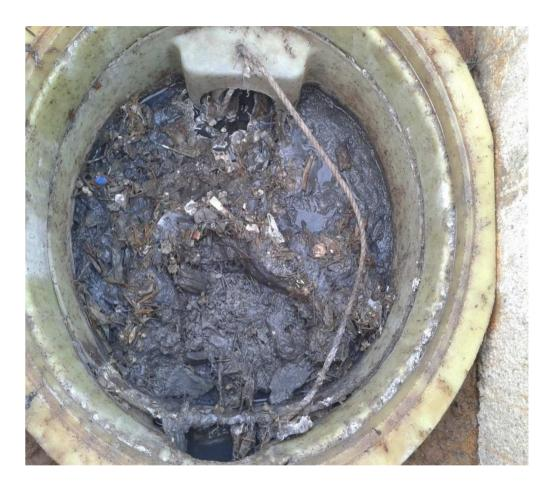
Sinon risque de colmatage et mise en danger de la pérennité des ouvrages de traitement La fosse se vidange dès 50 % de boue, le préfiltre une fois par an, le bac à graisse environ 2 fois par an.
